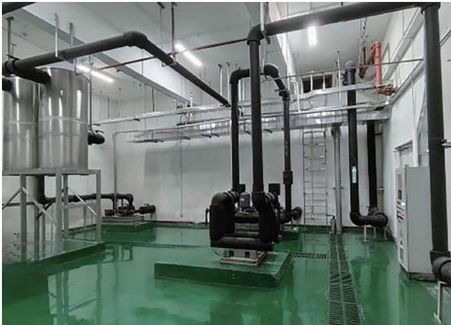
雨水冷凝水回收系统
